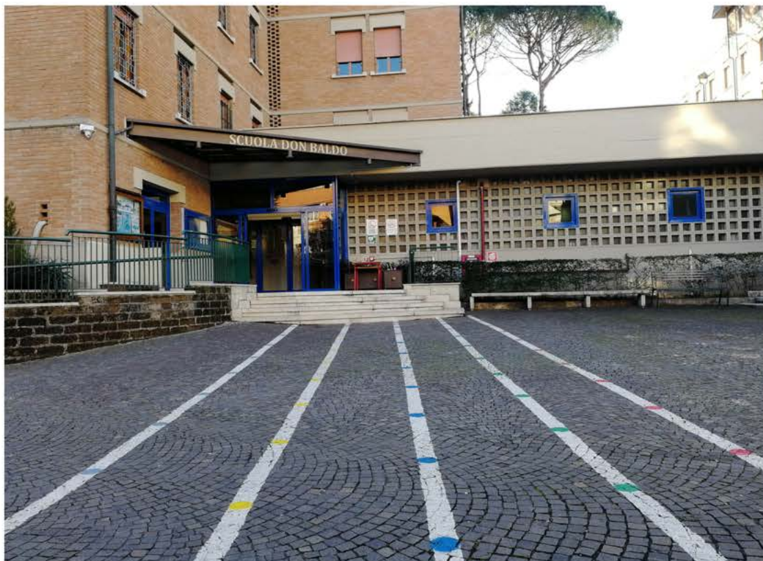
Sara Navarro Lalanda, Ingresso Istituto Don Baldo con segnaletica di sicurezza, 6 ottobre 2020
